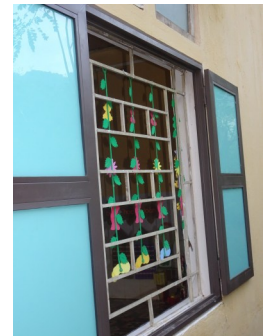
改修した教室の窓
