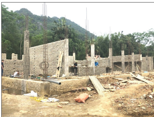
5月8日現在の状況（建設会社社長より入手）
