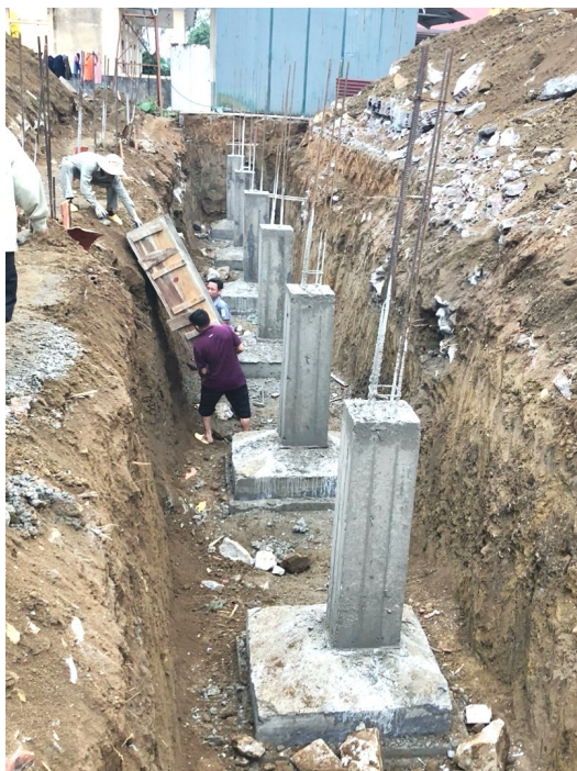
4月10日現在の状況（建設会社社長より入手）
